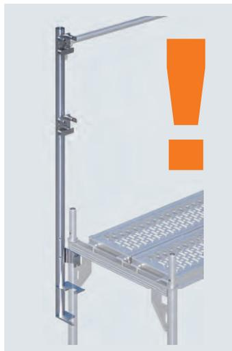
Der Aufbau der zweiten Ebene wird mit dem Aufsetzen der Vertikalrahmen auf die Rahmen der ersten Ebene fortgesetzt. Dadurch werden die unteren Beläge der ersten Ebene gesichert. (Achtung: Sicherungsgeländer im Bild rechts nicht abgebildet!)
