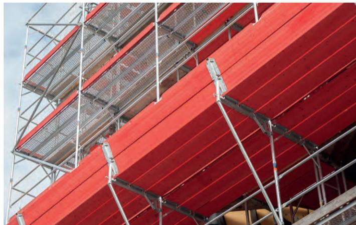
*Ausragende Auffangkonstruktionen wie diese lassen sich problemlos mit SUPER-Konsollösungen realisieren. Ohne Improvisieren, sondern mit voller Systemintegrität!*
