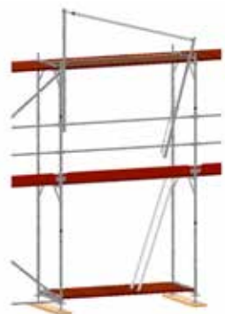
Bild 27: Einhängen des MSG-Geländers und zweiten MSG-Pfostens koppeln.
