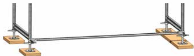
Bild 7: Aufbau des ersten Gerüstfeldes: Längsriegel
