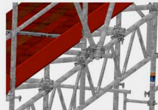
Bild 57: Anschluss der Diagonalen mit Normalkupplungen
