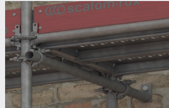
Bild 6.2c: Beispiel Verankerungsüberprüfung
